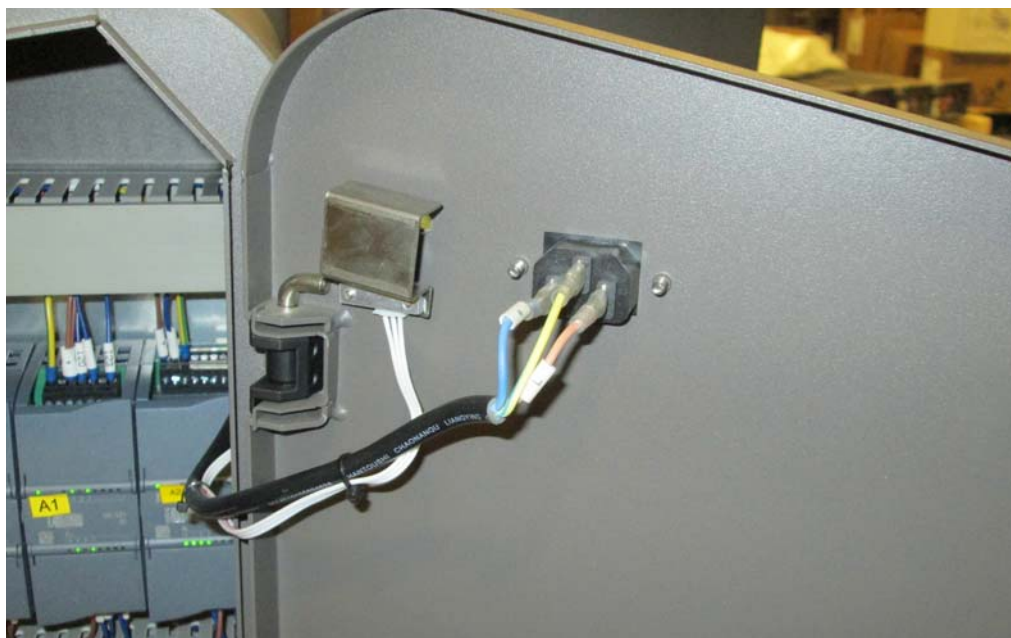
Figura 5 - 5 Conexiones del conector de carga y del indicador
