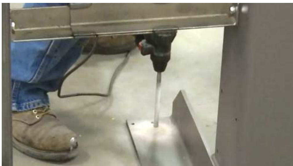
Figura 1 - 6 Perforar los Agujeros de Montaje
