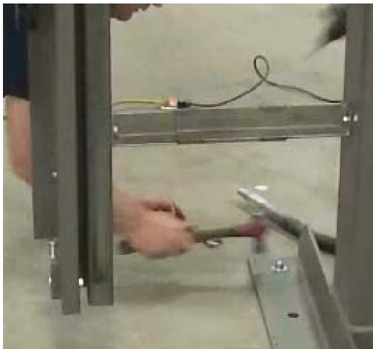
Figura 1 - 7 Instalando los Anclajes
